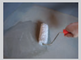
モルタル下地、粉ふき下地
